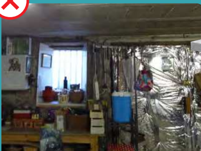
La fenêtre plexiglas et la porte de garage isolée confinent le sous-sol
