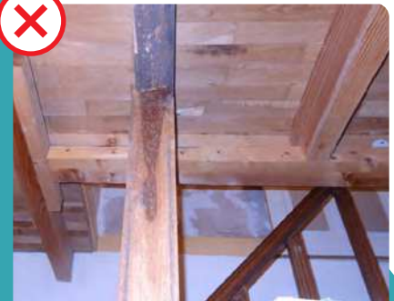
Escalier non isolé entre le sous-sol et le logement
