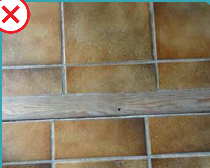
Défaut d'étanchéité au niveau des joints du carrelage au sol
